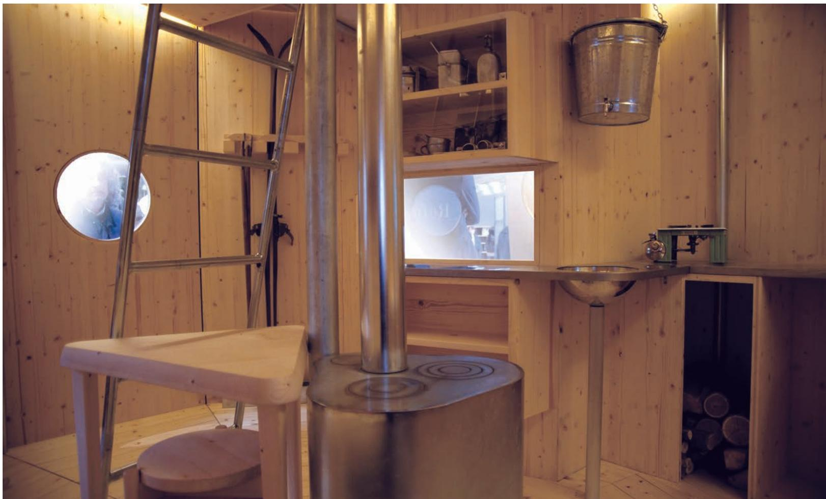
Il prototipo del Refuge Tonneau progettato da Charlotte Perriand nel 1938, realizzato da Cassina nel 2012, la cui struttura ricorda quella di una giostra per bambini, con un palo centrale e 12 spicchi attorno a esso.
